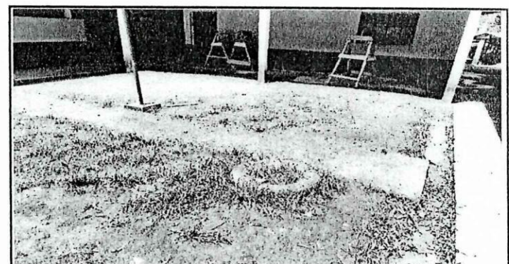
Foto 4: LOSA DE PATIO
